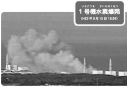
福島第一原子力発電所 1号機水素爆発の様子
